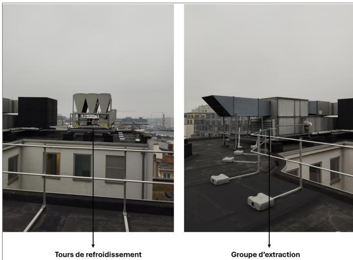
Photo 10 : Localisation des techniques en toiture (source : Advista)
